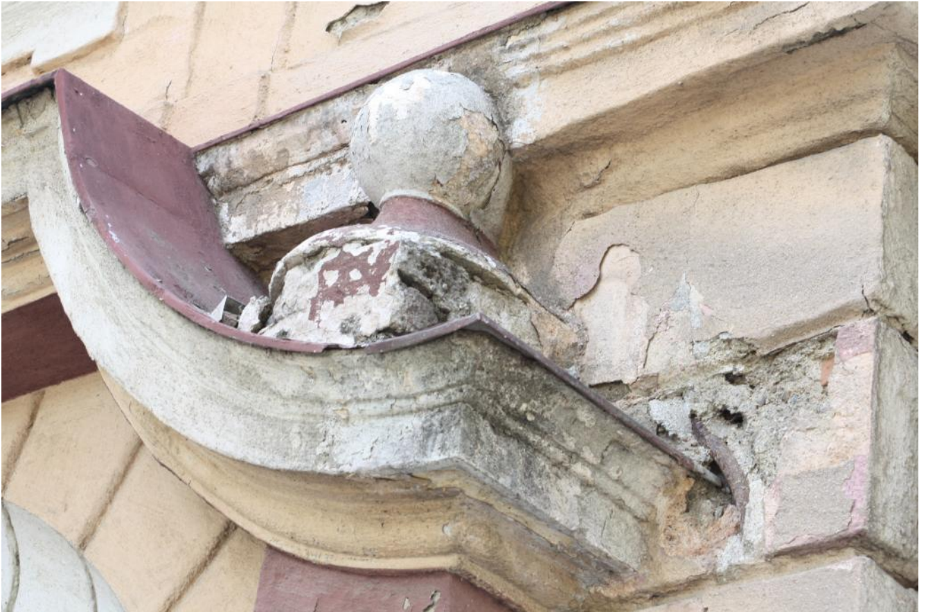
Príloha č.2 Stav budovy ZUŠ Moldava nad Bodvou SEPTEMBER 2011
